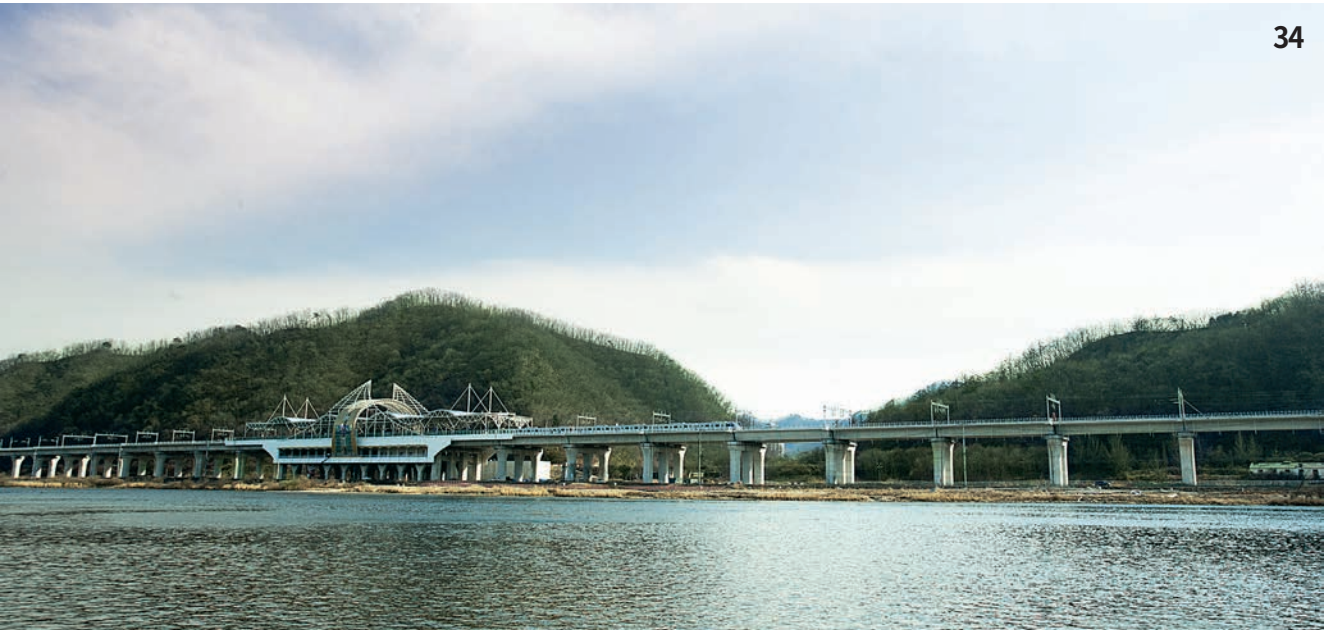
33. 현풍~김천간 고속도로 위치: 경상북도 김천시 -총연장 28.8km, 왕복 4차선 -교량 32개소(6.05km) -터널 4개소(7.7km) 공사기간: 2001. 12 ~ 2007. 12 34. 경춘선복선전철 제7공구 위치: 강원도 춘천시 -총연장 12.15km -교량 5개소 / 3.22km -터널 4개소 / 8.19m, 정거장 2개소 공사기간: 1999. 12 ~ 2011. 12
