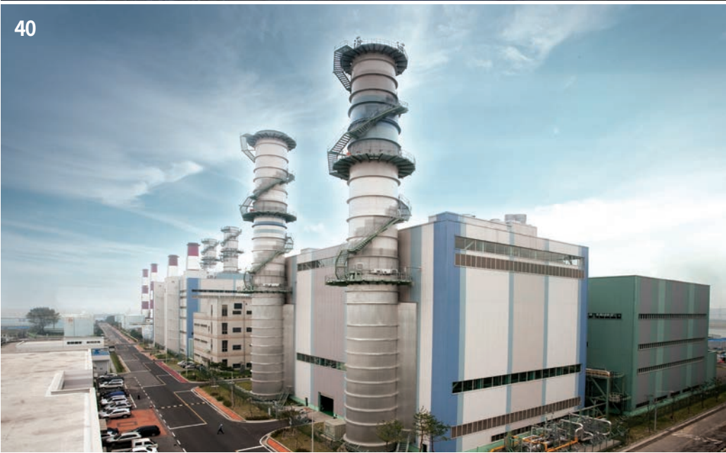
40. 인천복합화력발전소(2호기) 위치 : 인천광역시 서구 - 총발전량 500MW급 복합화력발전소 - 가스터빈 160MW×2 - 스팀터빈 180MW×1 공사기간 : 2007. 03 ~ 2009. 06
