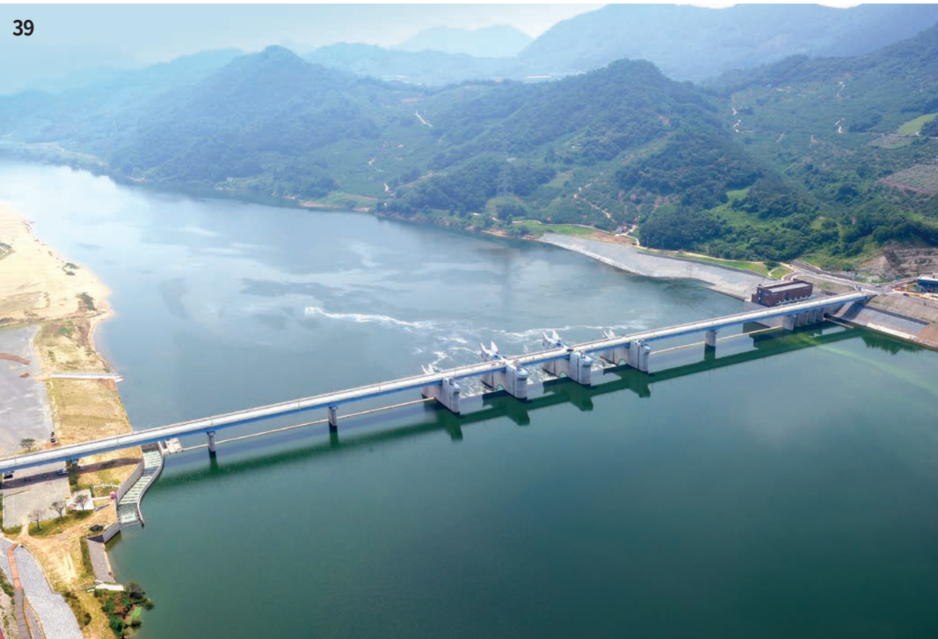
39. 낙동강살리기18공구사업 위치: 경상남도 함안군 -다기능보(L=566.1m×H=13.2m) -준설 3,421천㎥ -소수력발전소 1식 공사기간: 2009. 11 ~ 2012. 06
