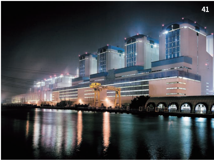
41. 당진화력 발전소(7,8호기) 위치 : 충청남도 당진군 - 500MWx2units 공사기간 : 2003. 12 ~ 2007. 12
