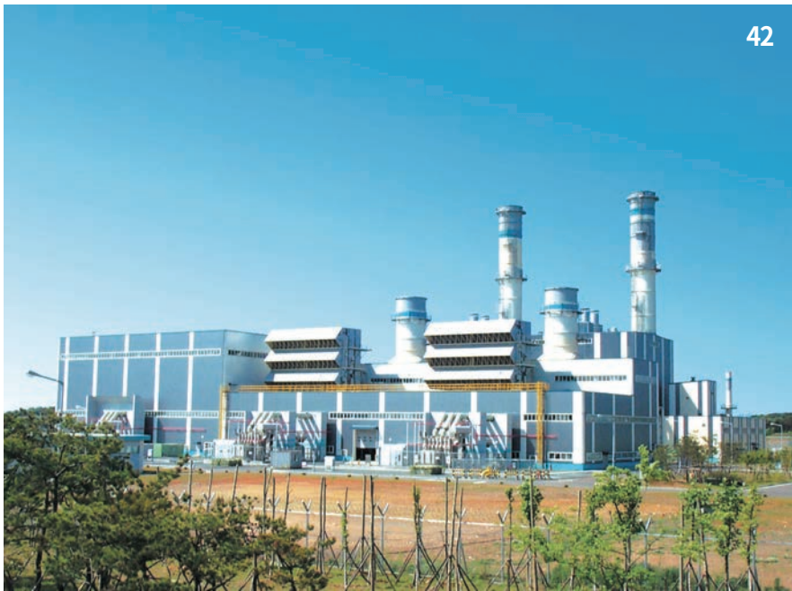
42. GS EPS 부곡 LNG 복합화력발전소(2호기) 위치 : 충청남도 당진군 - 총발전량 550MW급 복합화력발전소 - 가스터빈 180MW×2 - 스팀터빈 190MW×1 공사기간 : 2005. 12 ~ 2008. 03
