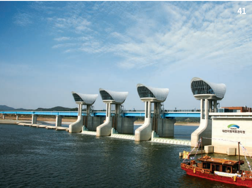
41. 금강살리기6공구(청남지구)사업 위치: 충청남도 부여군 -다기능보(L=680m×H=5.0m) -준설 3,057천㎥ -소수력발전소 1식 공사기간: 2009. 11 ~ 2012. 07
